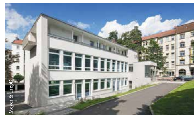
Untergeschoss und Hochparterre: Viel Raum für vielfältige Veranstaltungen
