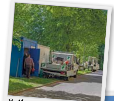
8. Mai Einrichtung der Baustelle
