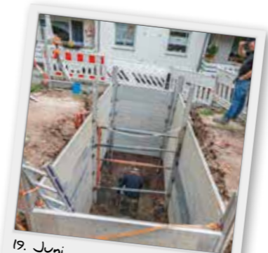
19. Juni Es geht in die Tiefe
