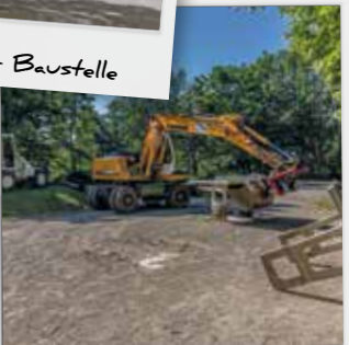
14. Mai Beginn der Abrissarbeiten
