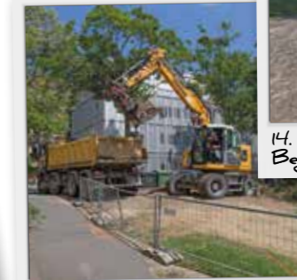
6. Juni: Die Aushub- und Erdarbeiten beginnen
