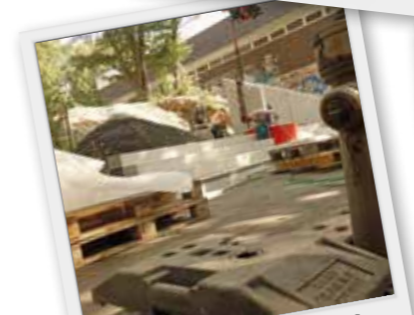
29. August: Bau der Treppe an der Königstorschule
