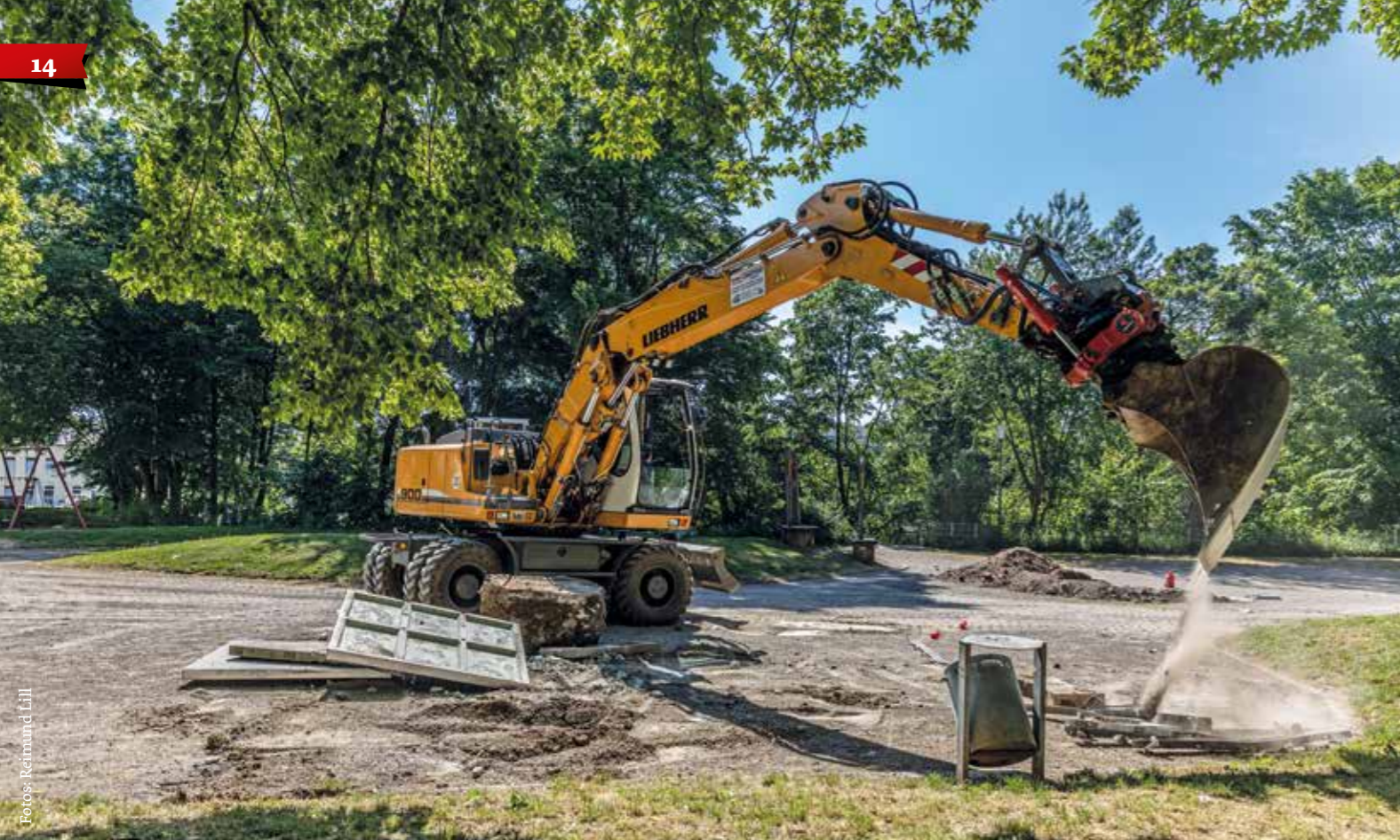
Die Bauarbeiten sind in vollem Gange
