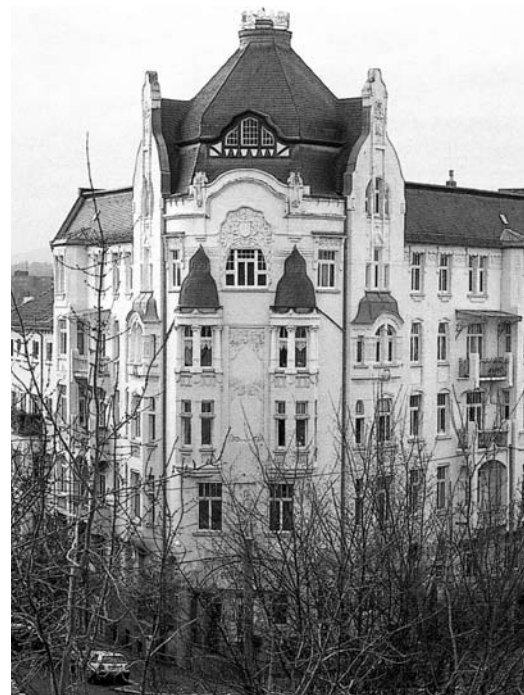
Goethestr. 67, Foto: Kulturdenkmäler in Hessen. Stadt Kassel II, hrsg. vom Denkmalpflege Hessen, Wiesbaden 2005, S. 257
